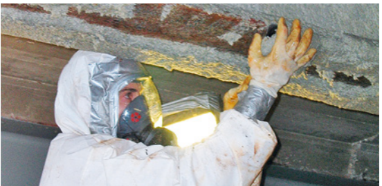
Asbestsanierung
