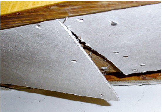
Asbesthaltige Leichtbauplatten
