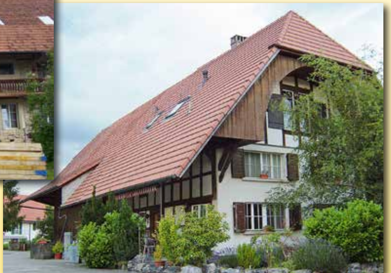
Umbau Bauernhaus Rapperswil
