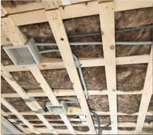
So sieht es «darunter» aus. Viele Rohre und Kabel damit der Strom fliesst wo er gebraucht wird.
