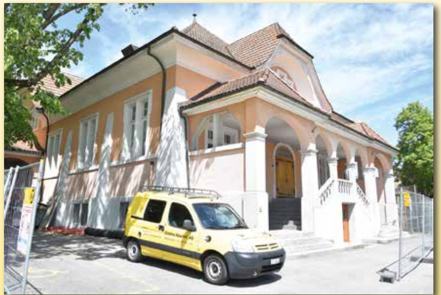
Einbau Bibliothek in alte Turnhalle Grenchen
