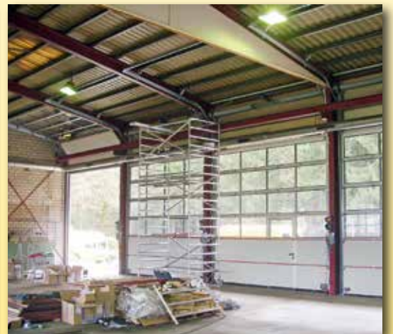
Sanierung Beleuchtung Bushalle
